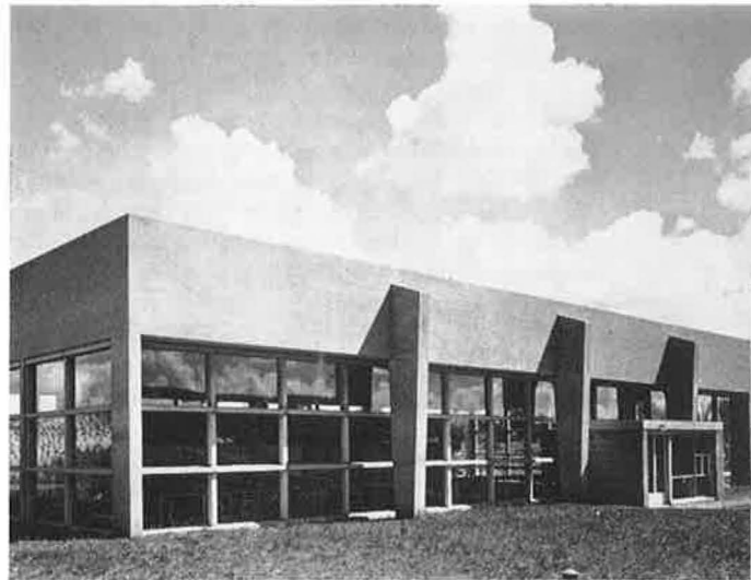
Gebouwen voor de Watertransport Mij Rijn-Kennemerland in Vogelenzang en Provinciaal Waterleiding Bedrijf in Noord-Holland in Castricum
