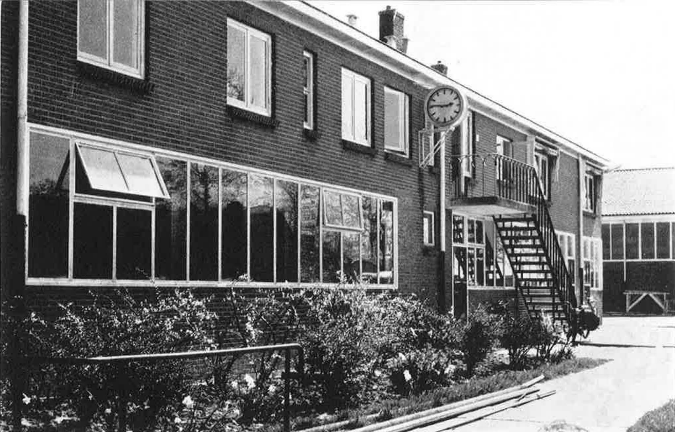
De nieuwe huisvesting van de afdeling Warmtetechniek van het CTI aan de Lange Kleiweg in Rijswijk
