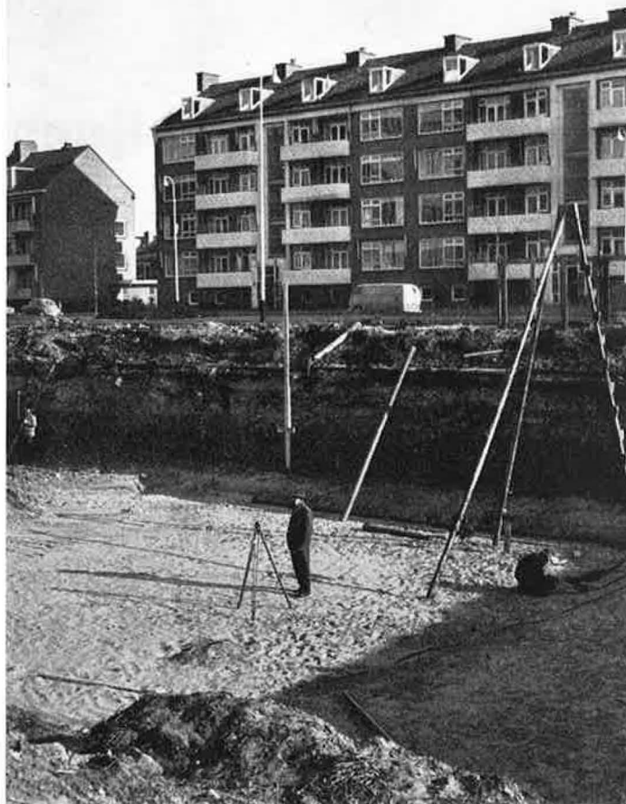
Foto hierboven: Een hoekje van het bouwterrein aan de Juliana van Stolberglaan.
