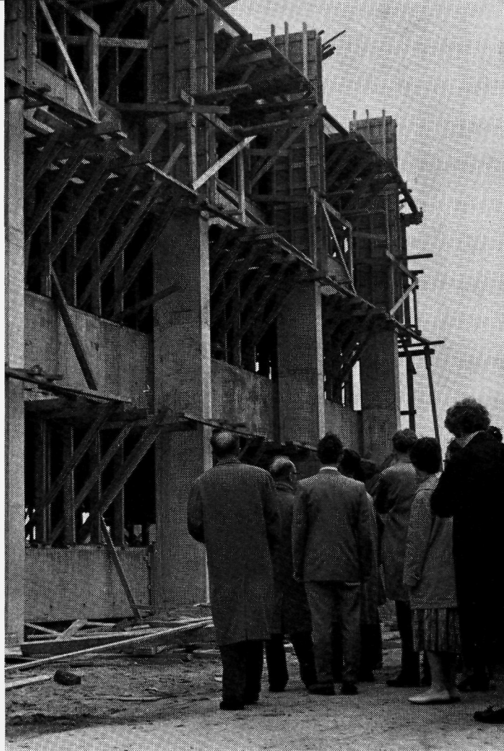
Aanzicht vakwerkconstructie van voorgespannen betonelementen
