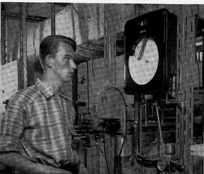
De droogtunnel met meet- en regelapparatuur.
