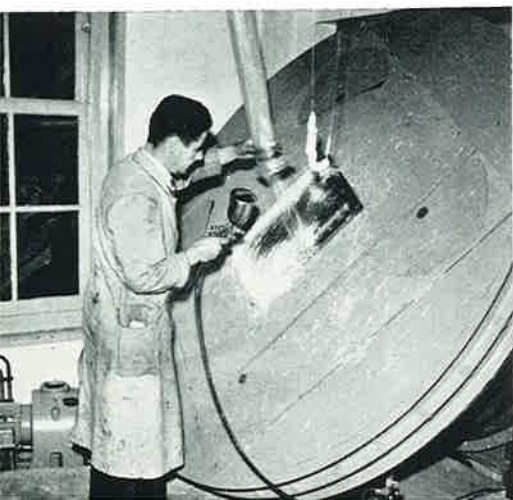
Preformen. Op een roterend gazen scherm worden gebakte glasvezels gezogen; tegelijkertijd word een bindmiddel op de vorm gespoten.
